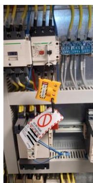
Fig. 3. Pulsando el botón rojo, sale el botón negro y el guarda motor secciona la alimentación / Pressing the red button automatically exits the black button. And then the circuit breaker cut off the power supply
