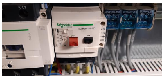
Fig. 2. Guardamotor cerrado, en condiciones de operación / Circuit breaker closed, in operation condition
