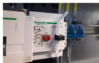
Fig. 2. Guardamotor cerrado, en condiciones de operación / Circuit breaker closed, in operation condition
