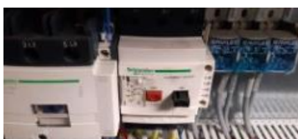
Fig. 3. Pulsando el botón rojo, sale el botón negro y el guarda motor secciona la alimentación / Pressing the red button automatically exits the black button. And then the circuit breaker cut off the power supply
